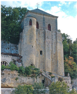
Vue de la tour des cloches érigée contre le coteau de tuf vers 1050. © UMR 7324 Citeres-LAT
