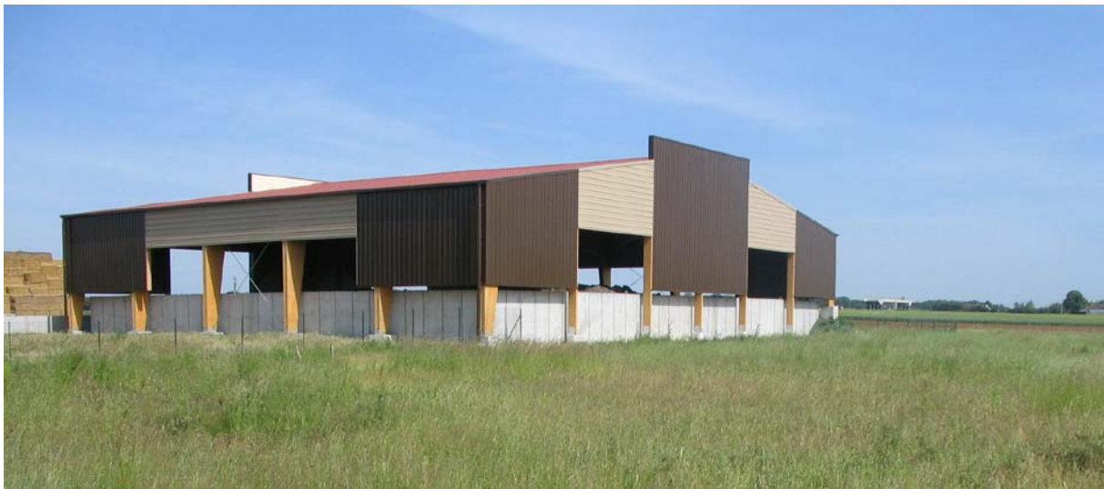
Figure 6 : Hangar de stockage des boues à Athée-sur-Cher
