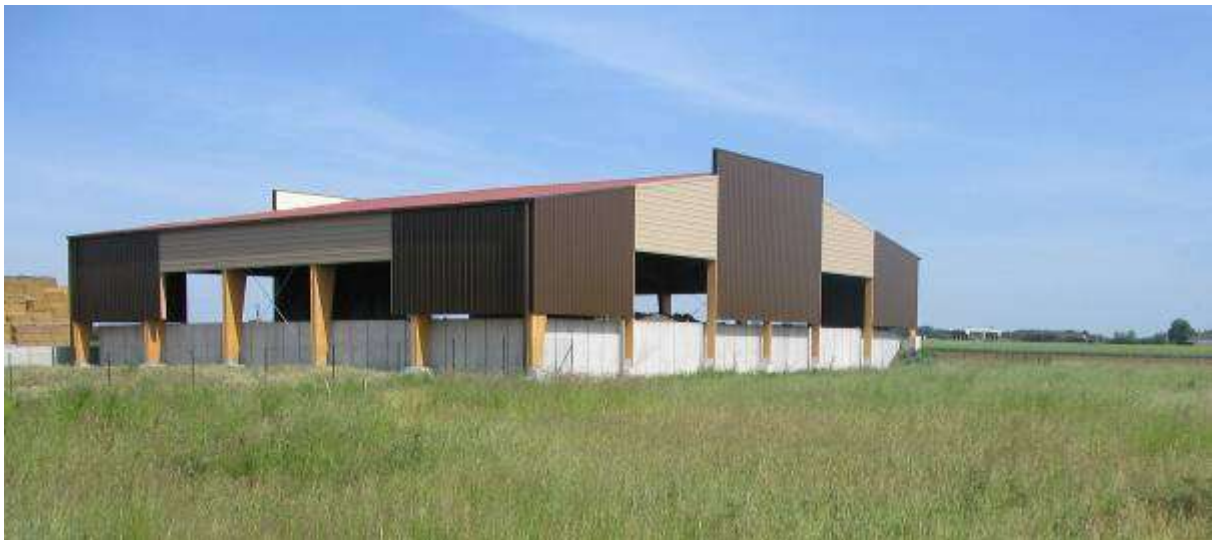
Figure 8 : Hangar de stockage des boues (Source : Serrano J., Athée-sur-Cher, 27/05/2005)
