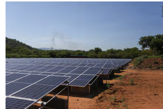
Installation de panneaux solaires en Afrique
